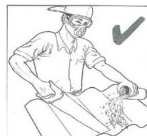
Realice los cortes y perforaciones de lámina mojado con agua previamente las zonas de corte.
